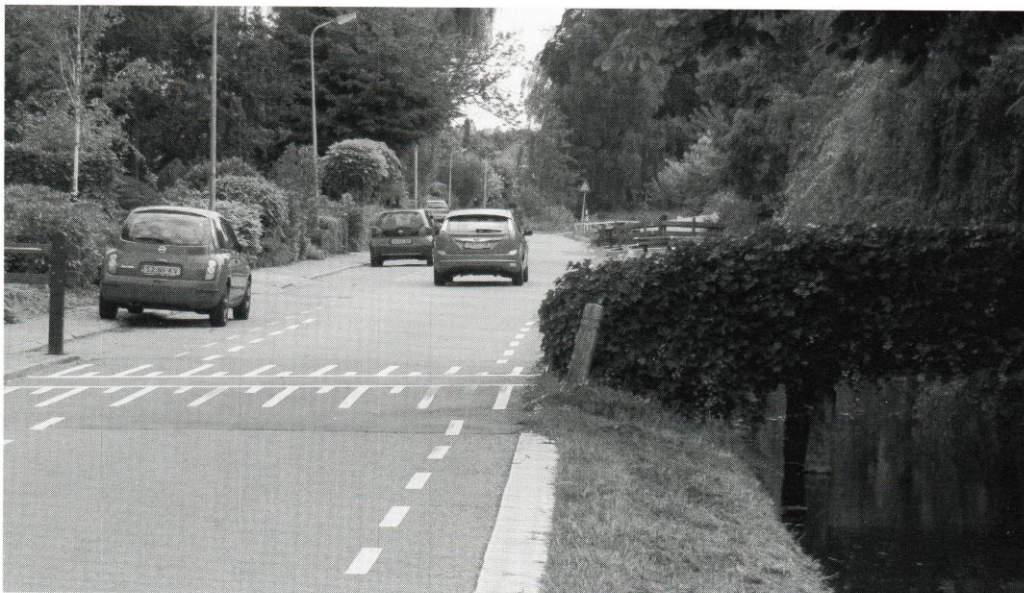
De 'Brugweg binnen de bebouwde kom' met wegversmalling, lage drempel, parkeerplaatsen en smal voetpad. De zuidelijke bermsloot is nog steeds aanwezig (situatie 2013)
