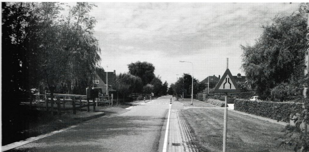
De 'Brugweg buiten de bebouwde kom' met wegversmalling (situatie 2013)
